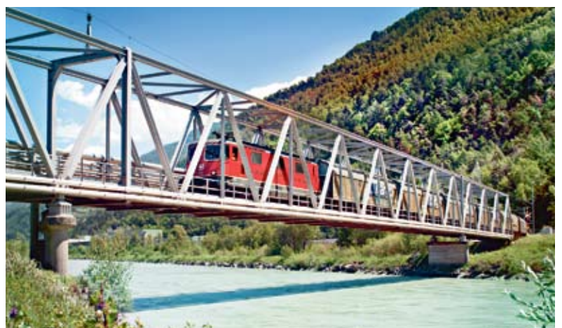
Trois à quatre fois par jour, les trains de marchandises franchissent le pont qu'Aproz a fait construire sur le Rhône il y a cinquante ans.
